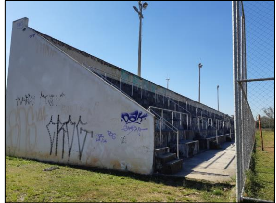
12196-7-2015 - CONSTRUÇÃO DO ESTÁDIO DO JD TUPY VALOR NO SIM-AM: R$ 1.549.110,68
